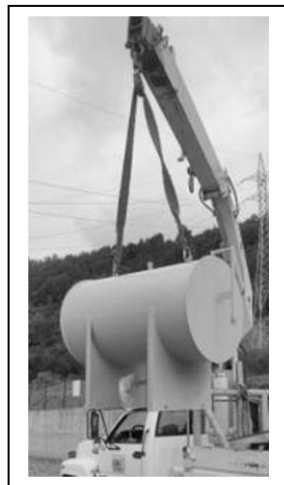
Figura 80: Montaje tanque conservador
