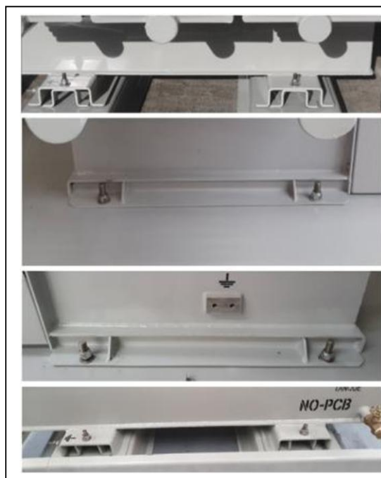
Figura 15: Anclaje con tornillos del transformador a la base
