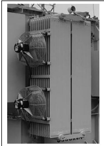
Figura 79: Instalación ventiladores
