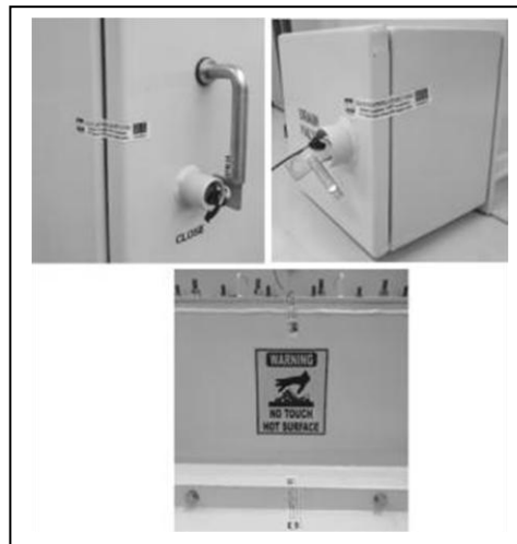
Figura 47: Sello de seguridad en partes removibles
